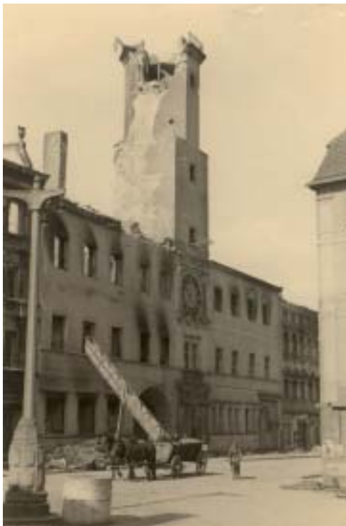
41. Zrujnowany budynek Ratusza wiosną 1945 r. (zdjęcie ze zbiorów J. Kulczyckiego)
